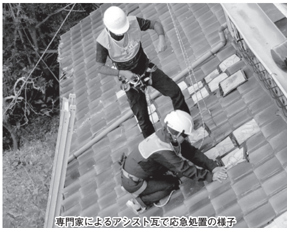
専門家によるアシスト瓦で応急処置の様子
